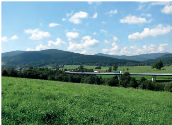
Pod silničním mostem na vysokých pilířích (estakádou) u Jablunkova mají divoká zvířata několik set metrů široký průchod, kudy mohou rušnou komunikaci bezpečně podcházet.
