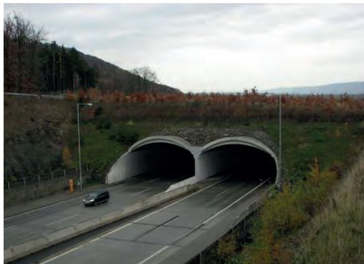
Zelený most poblíž Lipníku nad Bečvou – svou šířkou 93 metrů by byl i vhodný pro migraci velkých šelem, avšak jeho nevhodná lokalizace v těsné blízkosti obce a noční osvětlení značně snižují atraktivitu přechodu pro všechny velké savce.
